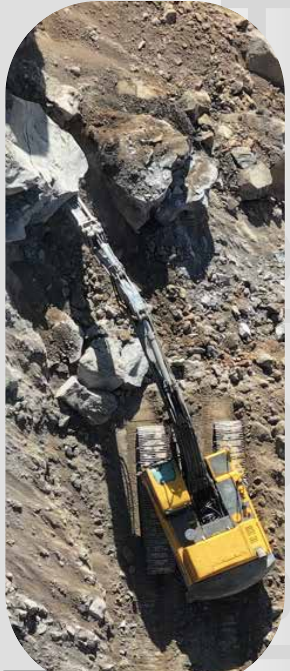
RESA CONSTRUCCIÓN DE CELDAS
