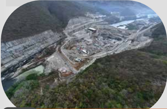
APYCSA PROYECTO: HIDROELÉCTRICO CH-II
