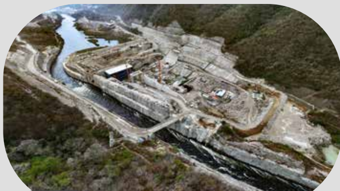
APYCSA PROYECTO: HIDROELÉCTRICO CH-II
