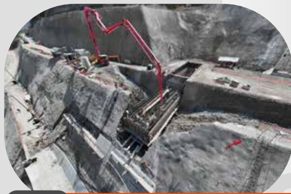
APYCSA PROYECTO: HIDROELÉCTRICO CH-II
